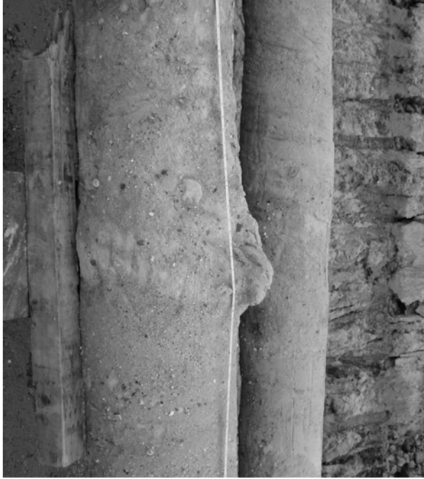
(a) Pile 'Wart'
